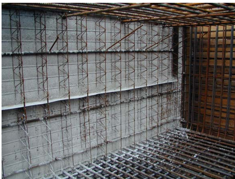
Abbildung 6: Mit Stremaform geschaltete hohe Fuge (ca. 2000 mm)
